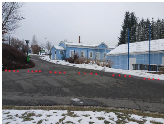
Markierung auf der Jahnstraße, Abzweig zum Sportplatz (Markierung ist nur noch sehr schlecht zu sehen / Erneuerung)
